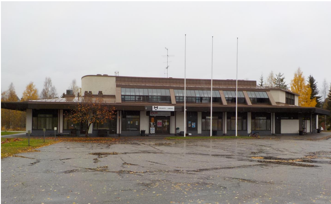
Kuva 5. Suunnittelualueen rakennuskantaa, kirjasto
