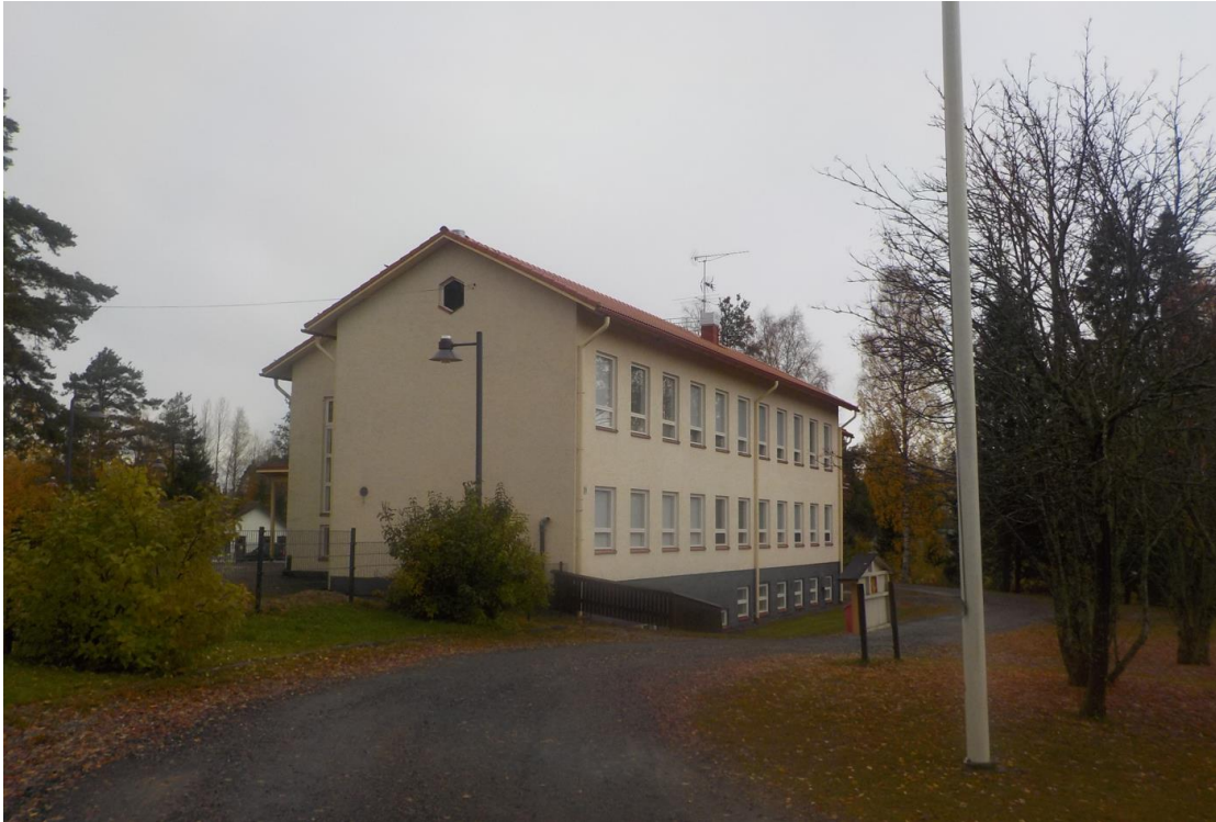
Kuva 4. Suunnittelualueen rakennuskantaa, koulu
