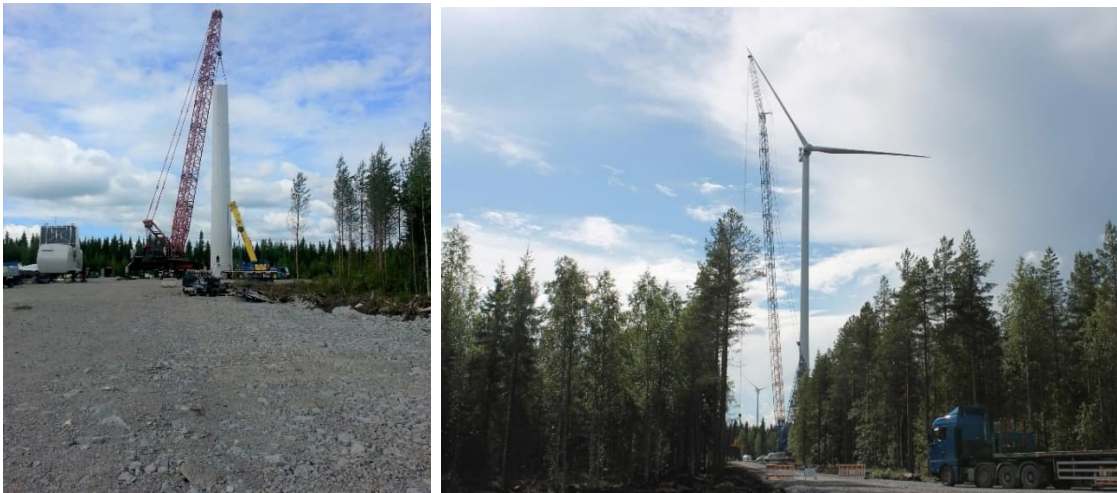
Kuva 3-7 Tuulivoimalan kokoaminen. © ABO Wind
