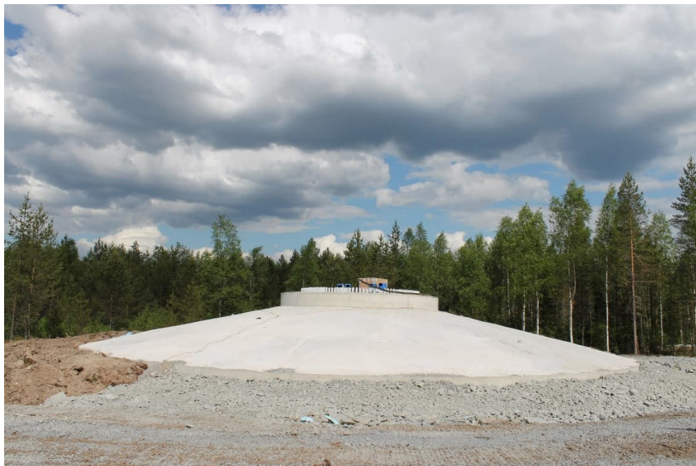
Kuva 3-8 Tuulivoimalan valmis perustus. © ABO Wind
