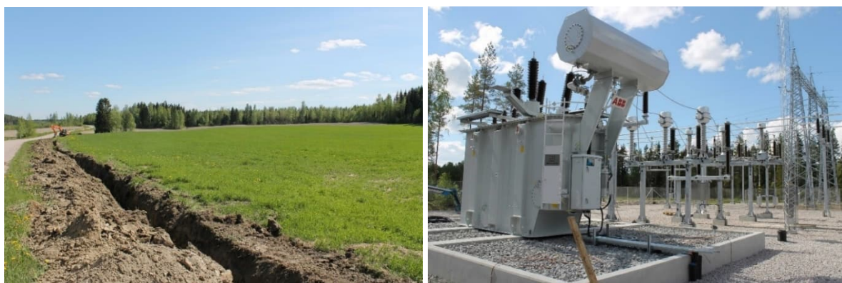
Kuva 3-2. Maakaapelin laskemistyöt (vasemmalla) ja esimerkki tuulivoimahankkeen 20/110 kV sähköasemasta (oikealla) © ABO Wind
